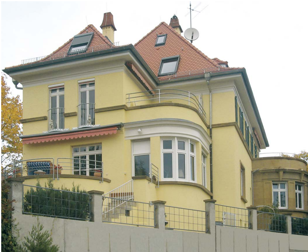
Fensterrenovierung mit Reich in einer Jugendstil-Villa in Stuttgart, Lenzhalde
